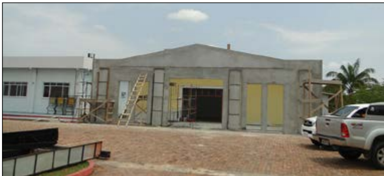
Foto 131: Visita a obra da Cidade da Justiça de Cruzeiro do Sul
