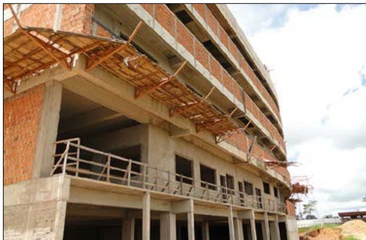
Foto 139: Foto da obra da Cidade da Justiça de Rio Branco
