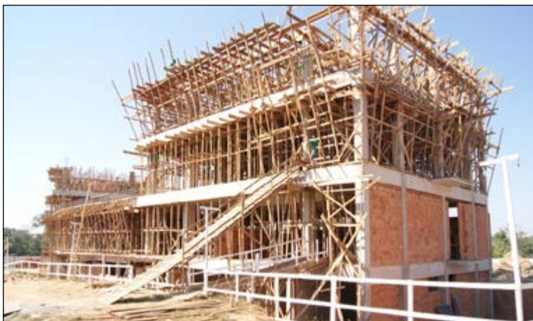
Foto 129: Acompanhamento da obra da Cidade da Justiça de Rio Branco
