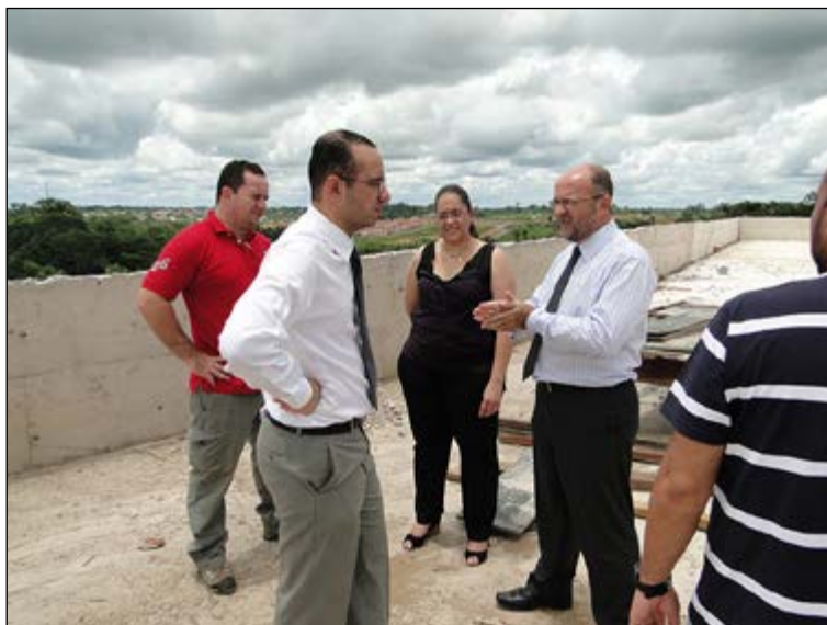
Foto 140: Foto da obra da Cidade da Justiça de Rio Branco
