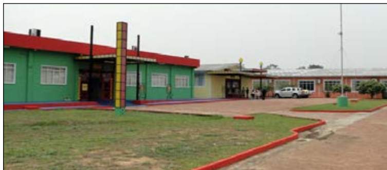
Foto 132: Visita a obra da Cidade da Justiça de Cruzeiro do Sul
