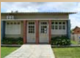
Comarca de Rodrigues Alves (não instalada)
