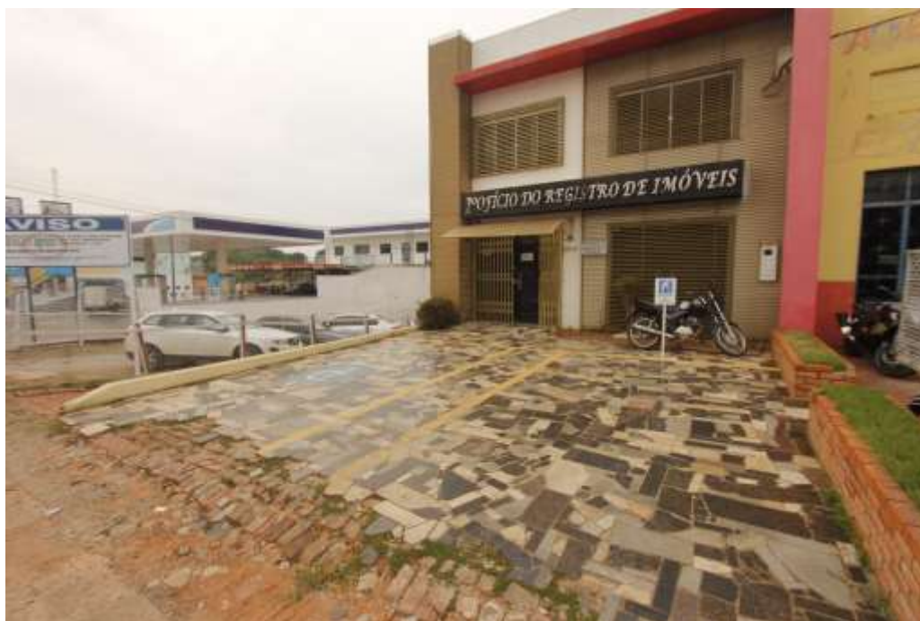
Fachada Principal do 1º Ofício de Registro de Imóveis – Rio Branco
