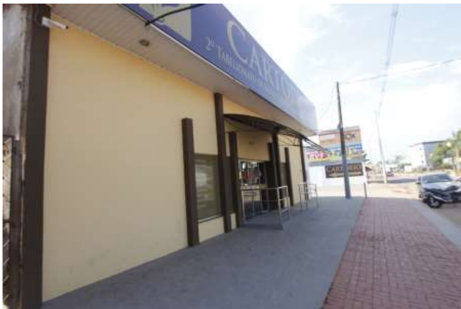
Fachada Principal da Serventia
