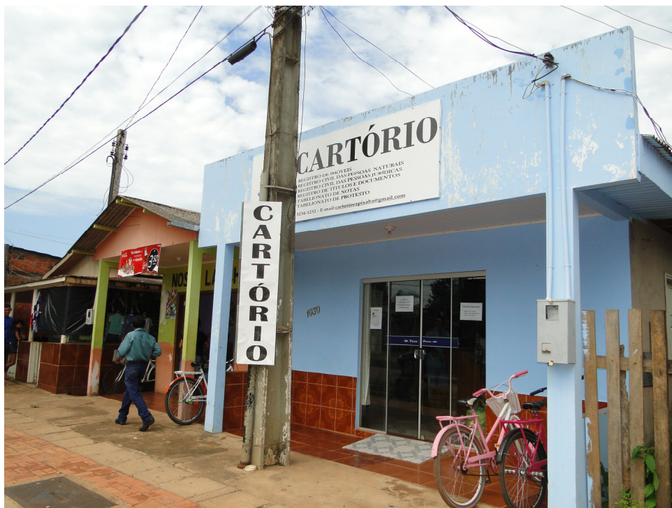
Fachada principal da Serventia
