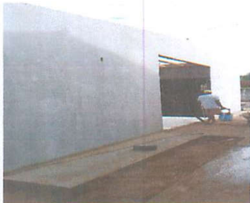
Foto 12 - Execução da calçada
