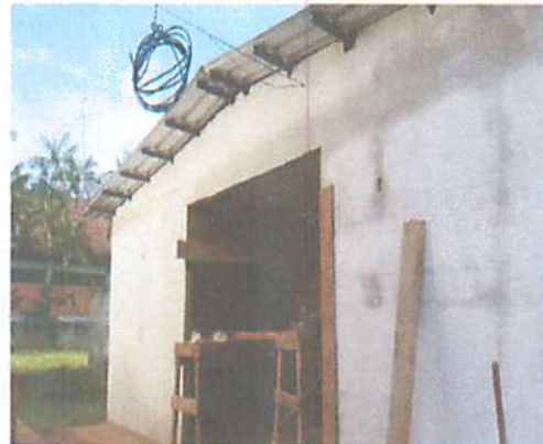
Foto 10 - Revestimento de parede concluído
