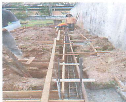
Foto 5 - Fôrma da viga baldrame
