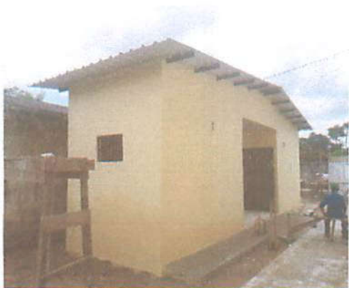
Foto 15 - Execução da pintura
