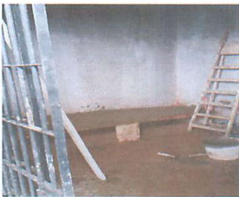
Foto 11 - Execução do banco de concreto
