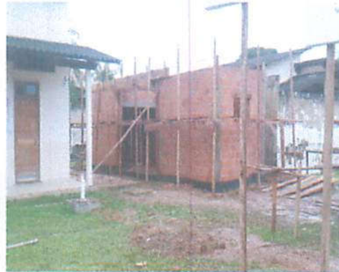
Foto 8 - Execução da alvenaria
