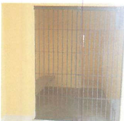
Foto 18 - Esquadria de aço concluída
