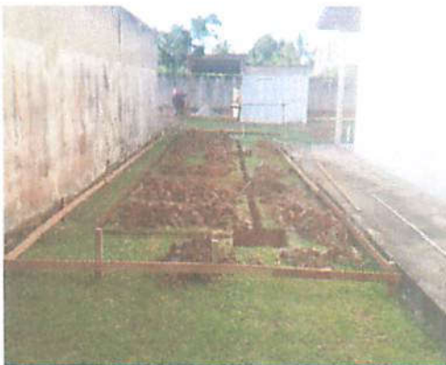
Foto 3 - Locação da obra
