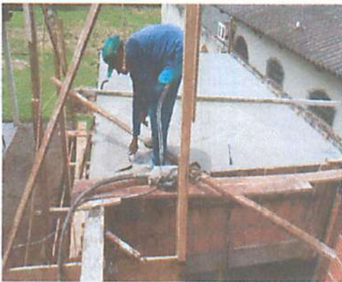
Foto 9 - Execução da laje
