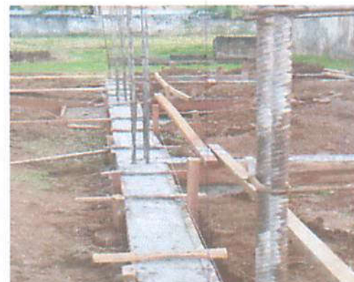
Foto 6 - Execução da viga baldrame
