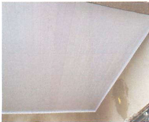
Foto 13 - Execução do forro e das instalações elétricas
