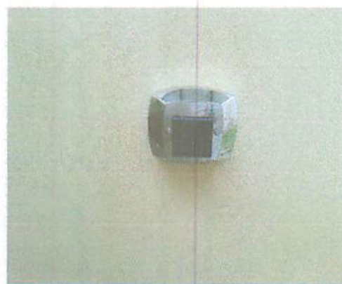
Foto 16 - Válvula de descarga concluída
