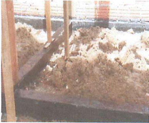
Foto 7 - Impermeabilização da fundação
