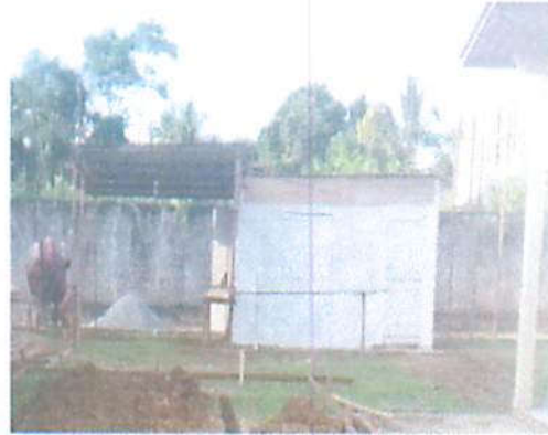
Foto 2 - Execução de depósito no canteiro de obras
