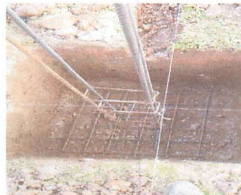
Foto 4 - Execução de vala para fundação
