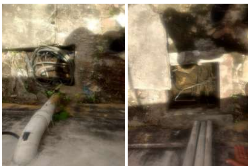
COMPROMETIMENTO DRENAGEM CAIXA DE PASSAGEM ELÉTRICA E AUSÊNCIA DE TAMPA PROTETORA
