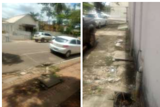
COMPROMETIMENTO DRENAGEM CAIXA DE PASSAGEM ELÉTRICA E AUSÊNCIA DE TAMPA PROTETORA
