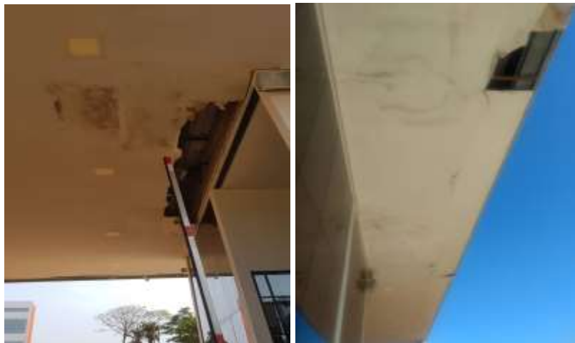
Reparo no forro de gesso guarita da Cidade da Justiça
