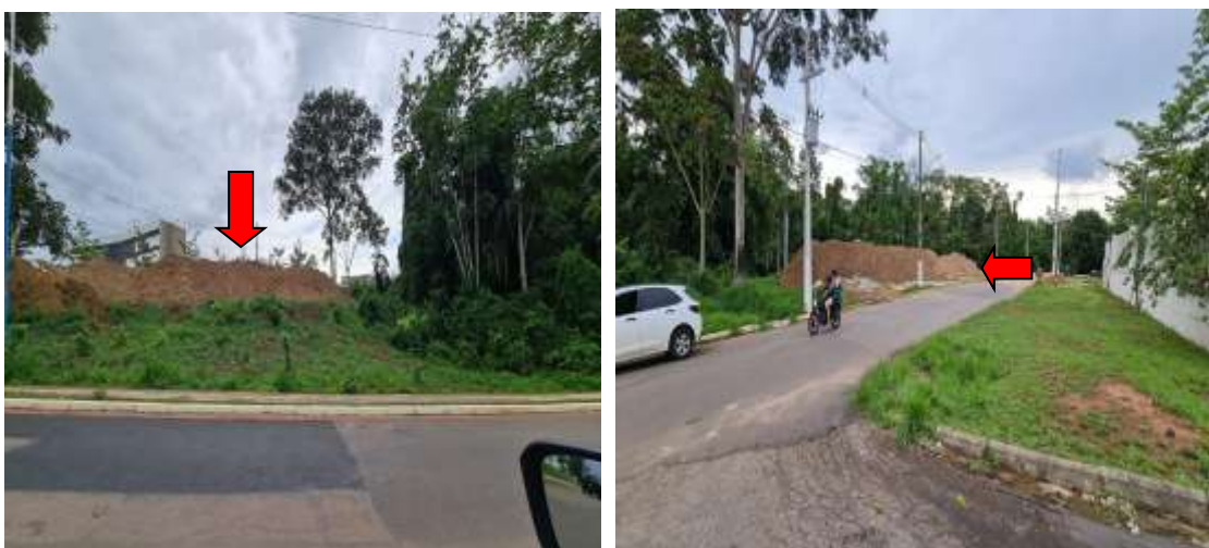
Depósito de terra em área inadequada
