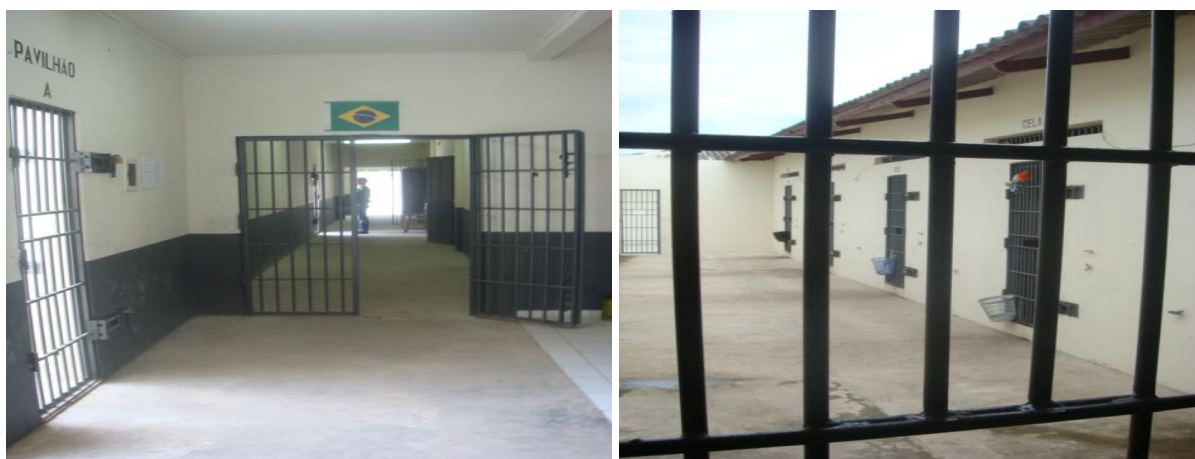
Corredor de acesso aos pavilhões e celas voltadas para o solário – ventilação e arejamento.
