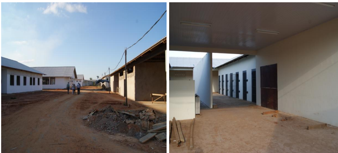
Detalhes evidenciando o estágio da construção da UP – Senador Guimard – AC
