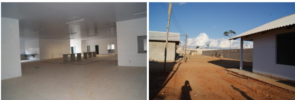
Detalhes evidenciando o estágio da construção da UP – Senador Guimard – AC
