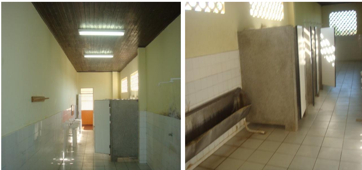
Banheiro em condições de higiene razoáveis, porém amplo e bem ventilado.
